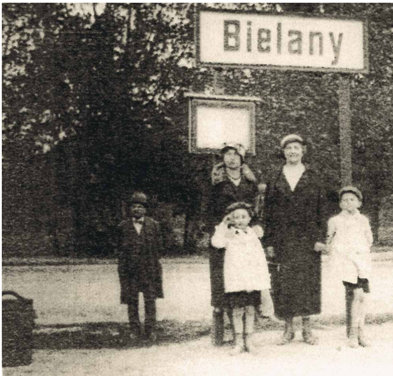
Przystanek kolei młocińskiej na Bielanych, km 5,0, lata 1929–1930, usytuowany przy szosie do Łomianek, a obecnej ulicy Marymonckiej. Zbiory E. Aftańskiego z dzielnicy Marymont.
