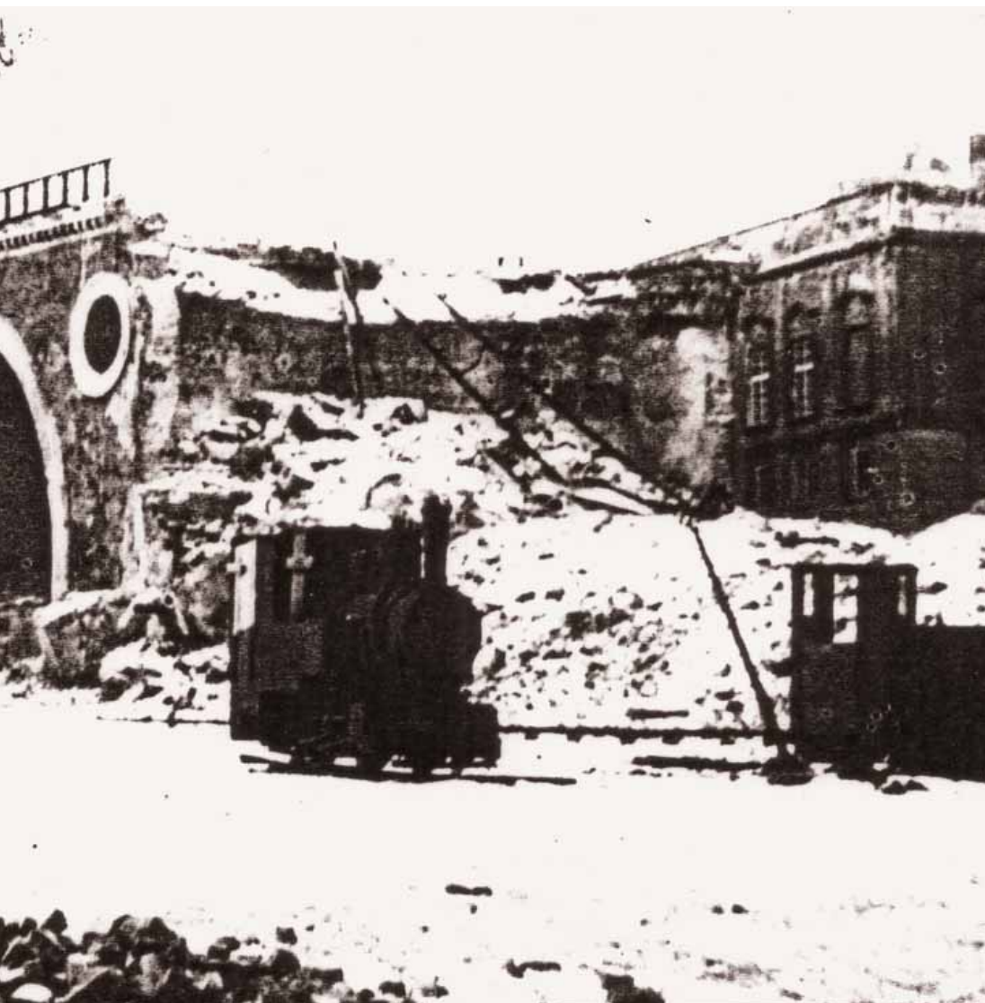
Już w grudniu 1946 r. na przyszły plac budowy Trasy W-Z zaczęto sprowadzać elementy kolejki budowlanej, jak szyny i tabor. Na tle wiaduktu Pancera stoi parowóz firmy Henschel typ RIESA, a z prawej strony lokomotywa spalinowa firmy DEMAG.
