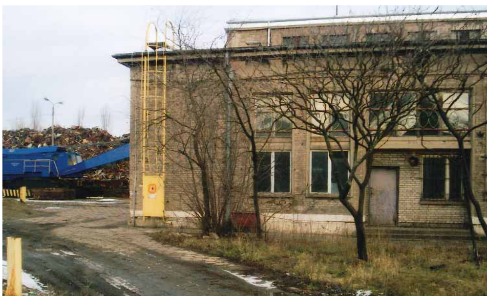
Zachodnio-południowa ściana boczna budynku Wydziału Kolejowego z wejściem do holu zegarowego.
