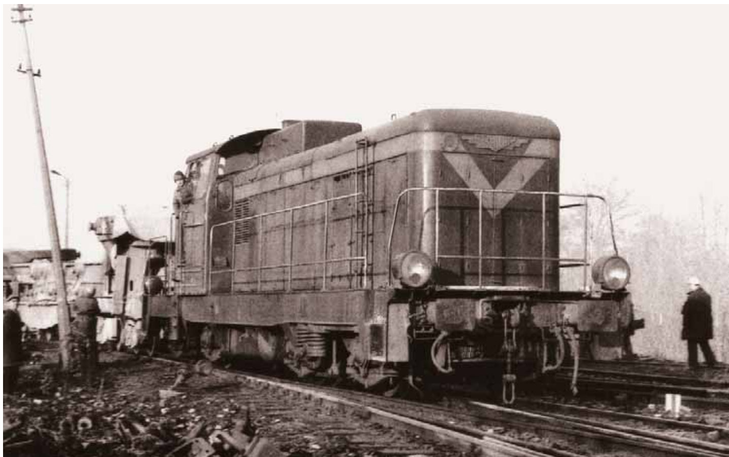
Lokomotywa spalinowa SM 42-2193 wyciąga puste wagony gruszki z kafaru nr 2 na stację Buraków, żeby je zaprowadzić na halę lejniczą stalowni.
