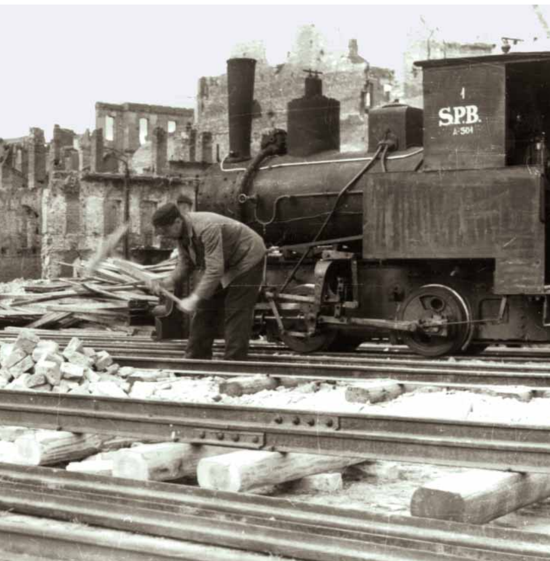
Podbijanie torów gruzem w parowozowni przy placu Krasieńskich. Widoczny parowóz typu Bn2t firmy Krauss nr 1 należący do Stołecznego Przedsiębiorstwa Budowlanego, marzec 1945 r.
