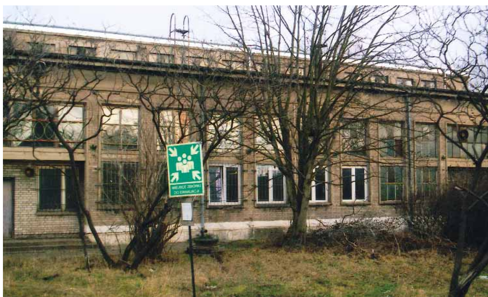
Ściana boczna budynku Wydziału Kolejowego – sześć okien górnych to dawne biura i gabinet kierownika wydziału, a dolne okna to szatnia pracowników warsztatu, stołówka i kuźnia.
