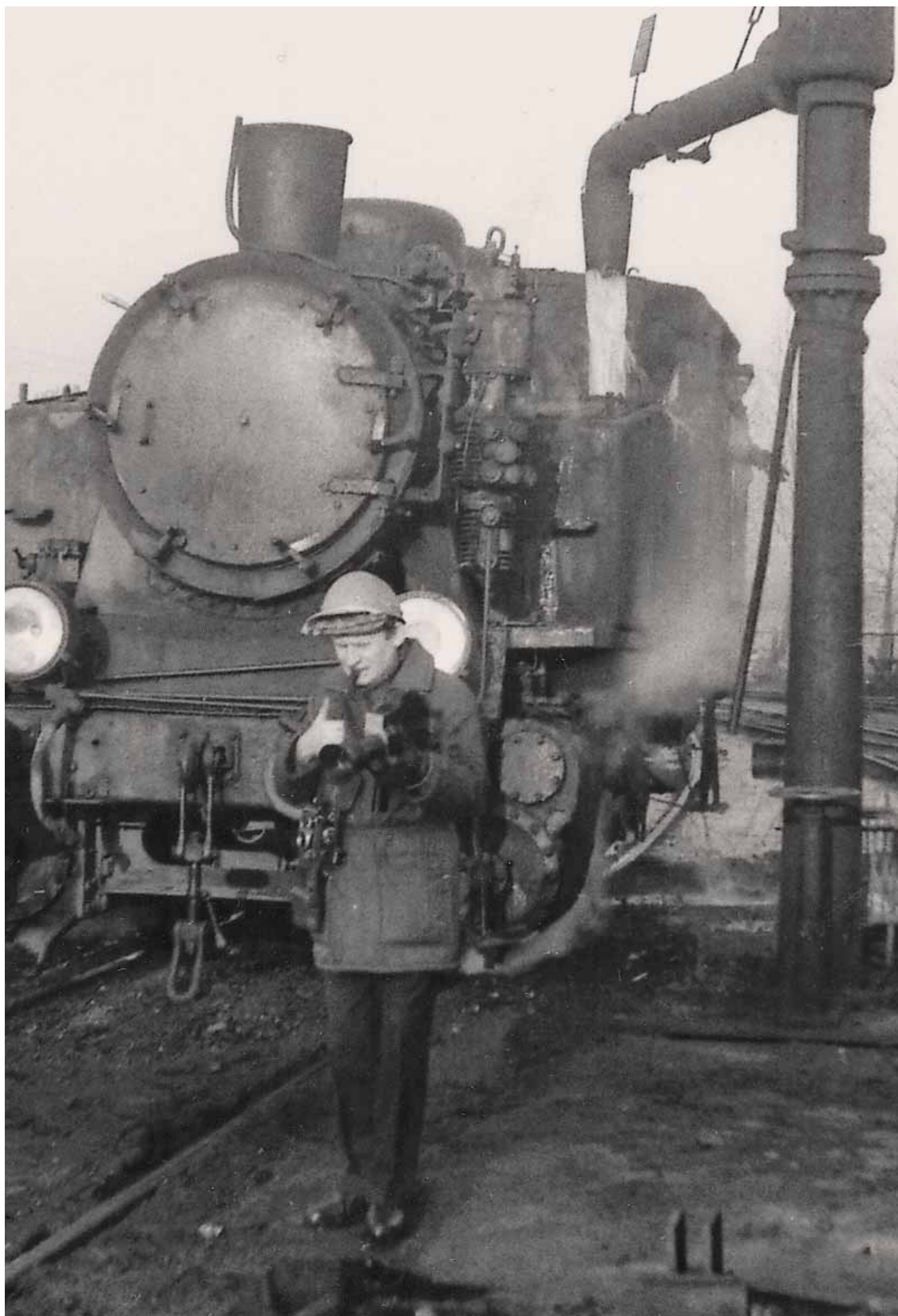
Nabór wody z żurawia na terenie parowozowni do parowozu typu Ferrum TKh 5584.
